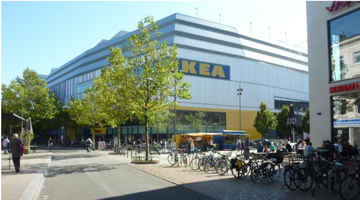
Abbildung 1: Das 2014 eröffnete IKEA-Haus in Hamburg Altona. Quelle: Heiner Schote.
