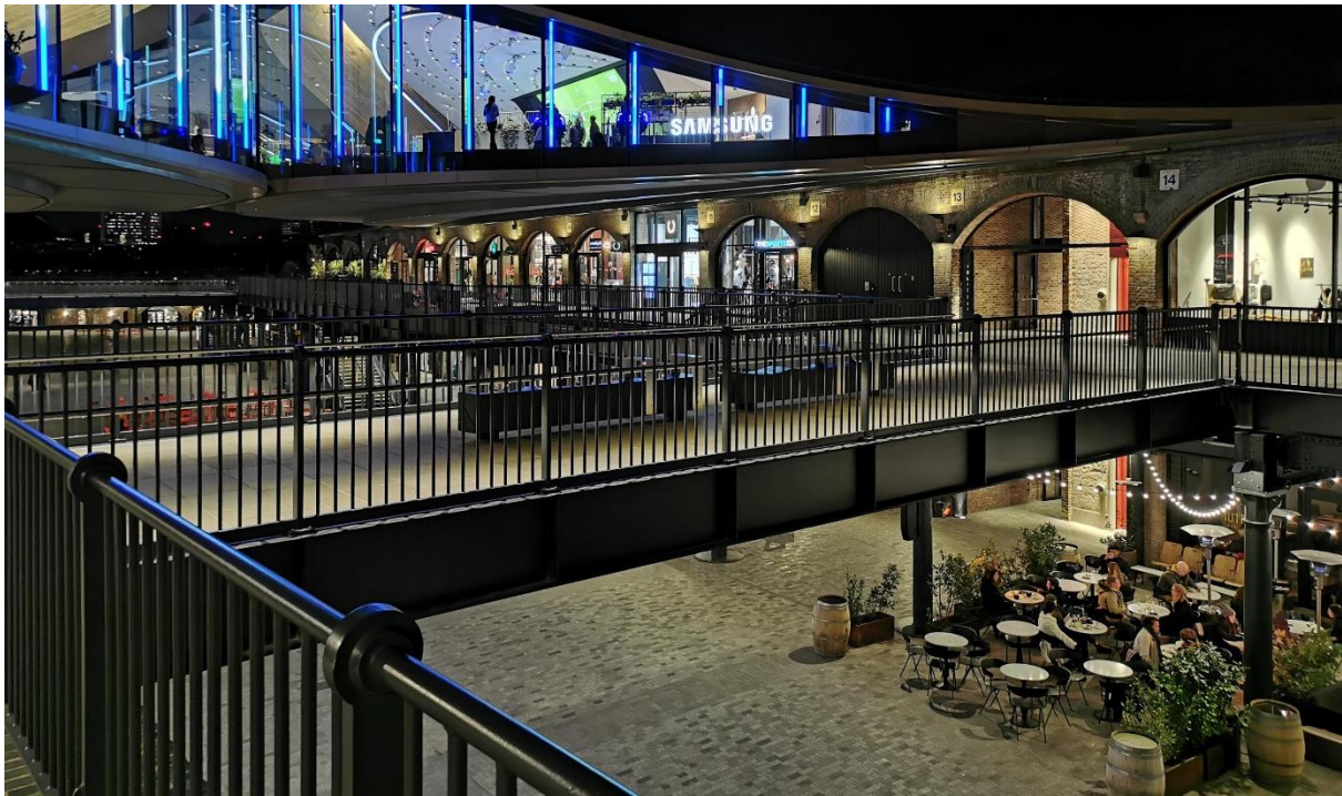
Abbildung 1: Offene Freifläche im Coal Drops Yard. Quelle: Tim Haas 12.01.2020.
